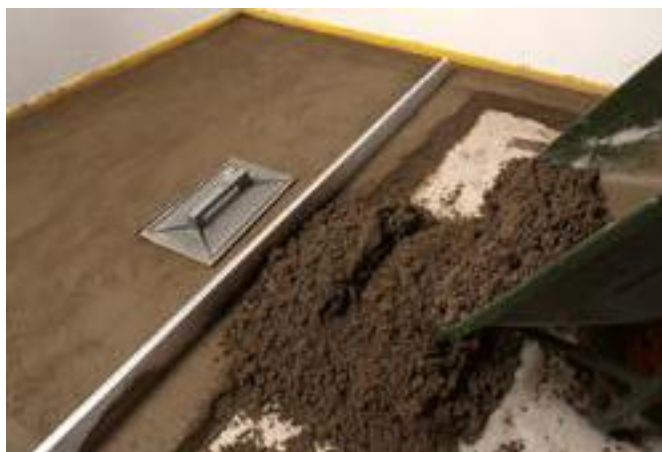
Укладка стяжки на основе ТОРСЕМ PRONTO
