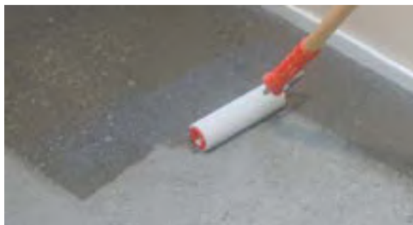
Нанесение PRIMER G
