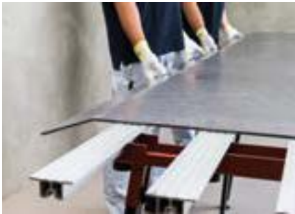
Плитка ломается на две части
