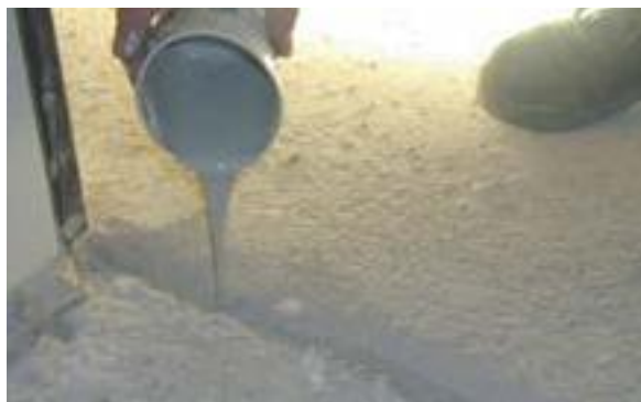
Заливка трещин в основании с помощью EPORIP
