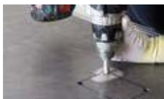
Порядок действий по созданию прямоугольного отверстия
