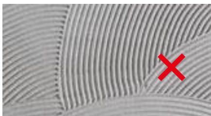
Правильное и неправильное нанесение клея
