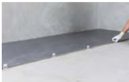
Установка разделителей в требуемое положение
