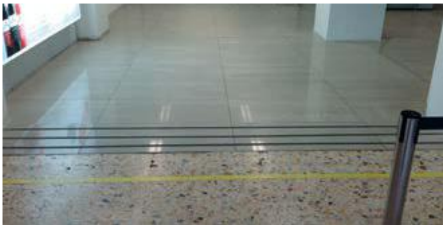
Укладка плитки поверх существующих полов
