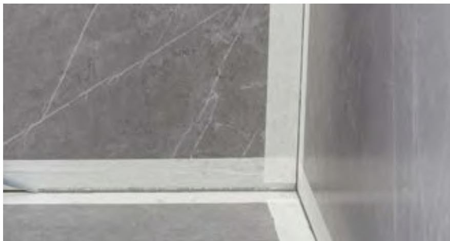
Герметизация шва по периметру с помощью MAPESIL AC
