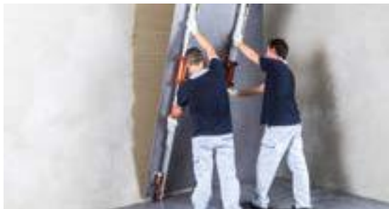
Укладка плитки на стену
