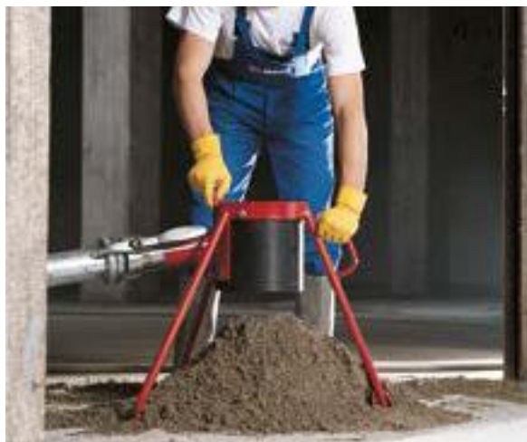
Укладка стяжки с помощью ТОРСЕМ PRONTO
