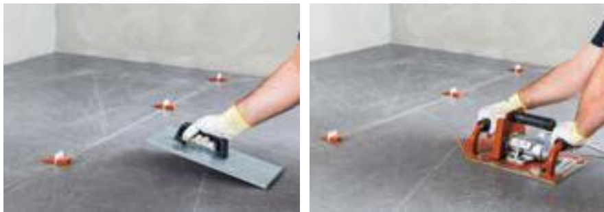
Простукивание плитки вручную или с помощью вибропанели
