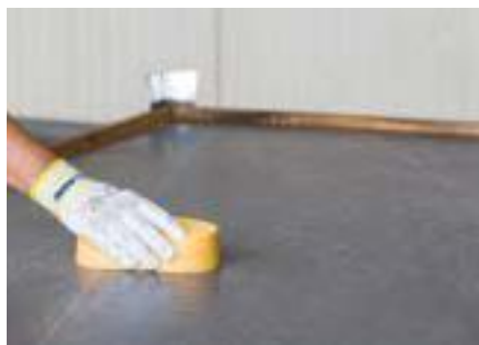
Очистка поверхности плитки
