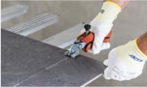
Разламывание плитки с помощью щипцов для надлома
