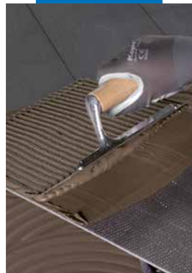
Нанесение клея на тыльную сторону плит
