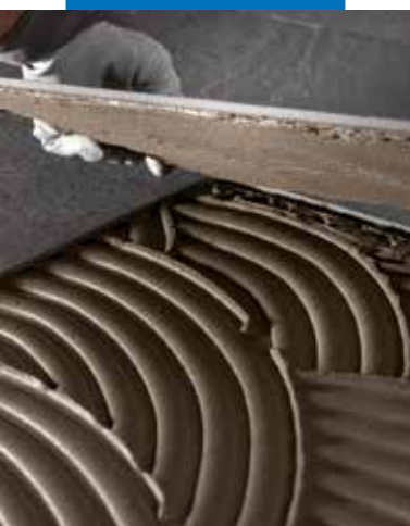
Укладка на пол тонкого керамогранита
