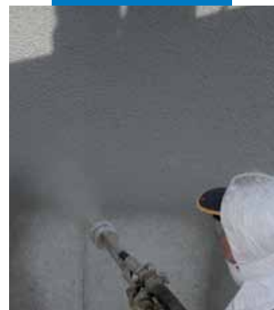
Нанесение Mapelastic на виадук путем распыления
