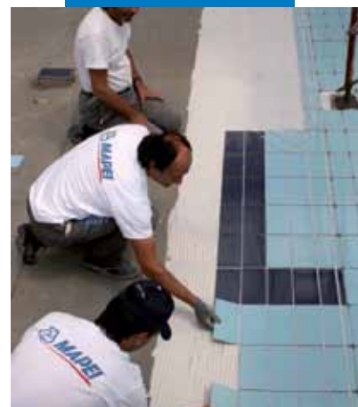
Укладка керамической плитки на Mapelastic в бассейне
