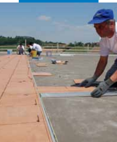
Укладка керамической плитки с применением Kerabond + Isolastic
