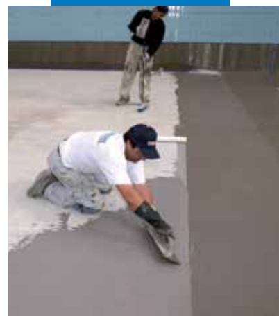
Гидроизоляция бассейна с применением Mapelastic
