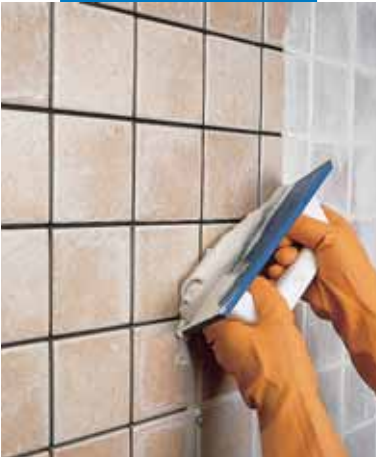
Заделка швов плитки одинарного обжига мастерком
