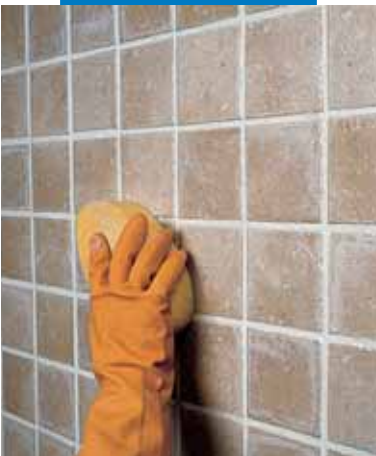
Отделка плитки одинарного обжига губкой
