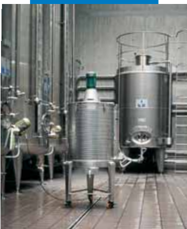
Пример заделки швов в винном производстве
