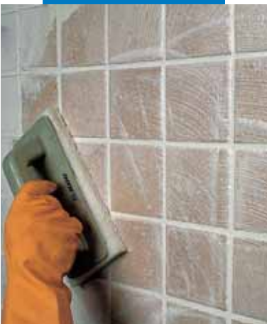
Отделка плитки одинарного обжига теркой Scotch-BriteR
